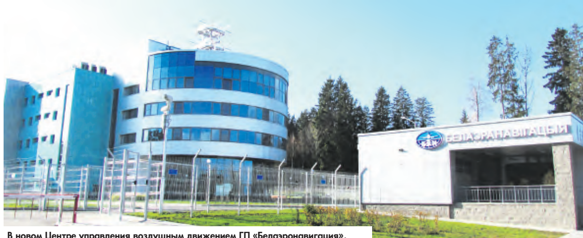
В новом Центре управления воздушным движением ГП «Белаэронавигация», возведенном в поселке Сокол, обеспечены беспрецедентные меры безопасности.
