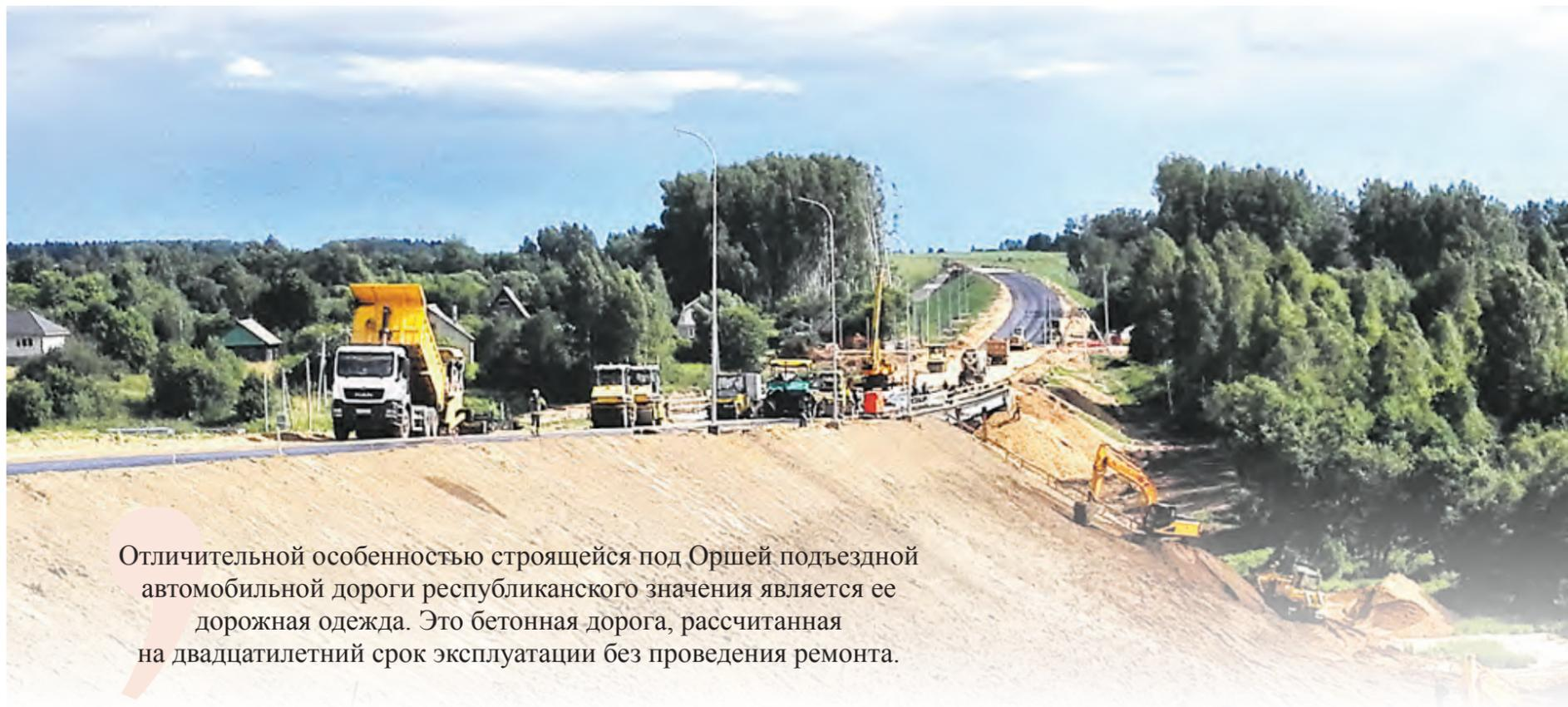
Отличительной особенностью строящейся под Оршей подъездной автомобильной дороги республиканского значения является ее дорожная одежда. Это бетонная дорога, рассчитанная на двадцатилетний срок эксплуатации без проведения ремонта.
