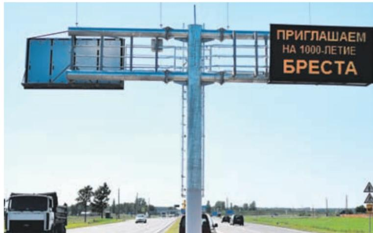
Впервые в Республике Беларусь на автомобильной дороге для установки двух табло переменной информации (ТПИ) в разделительной полосе была применена оцинкованная металлическая Т-образная опора. Использование такого вида опоры позволило сократить на 15% стоимость строительно-монтажных работ (в сравнении с установкой двух Г-образных опор) и обеспечить современный вид международного автотранспортного коридора. При этом на ТПИ можно выводить не только информацию о метео-
