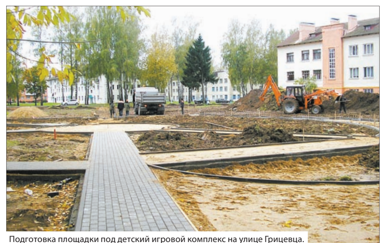
Подготовка площадки под детский игровой комплекс на улице Грицевца.
