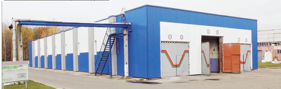
Механическая мойка после реконструкции.
