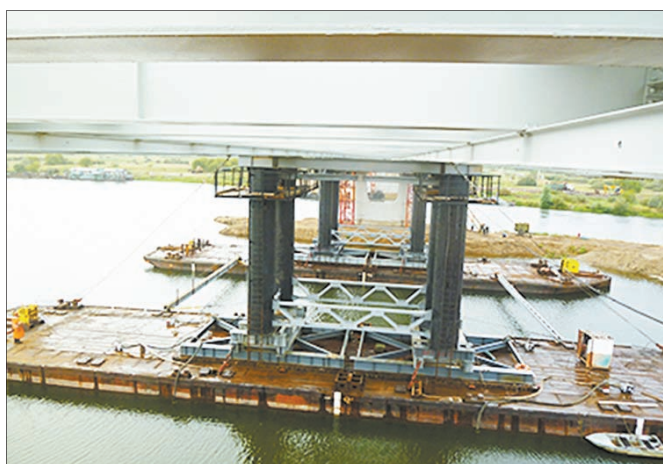
Процесс установки ферм.
