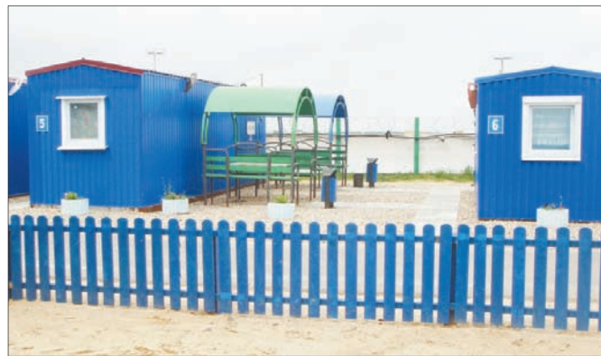
Предприятие возводит строительные городки для проживания специалистов в непосредственной близости от объектов.
