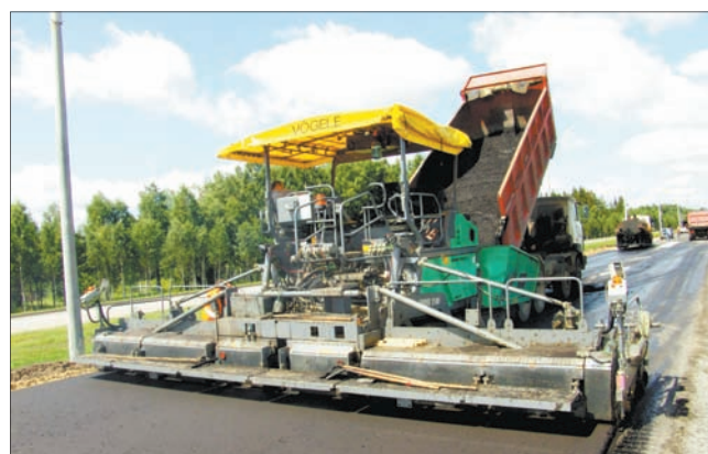
В строительстве и на реконструкции магистралей дорожники СМТ № 8 используют современный бетоноукладчик со скользящей опалубкой GOMACO GHP280.
