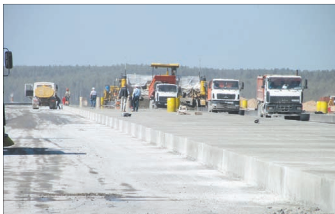
ОАО «СМТ № 8» задействовано на строительстве взлетно-посадочной полосы в Национальном аэропорту Минска.
