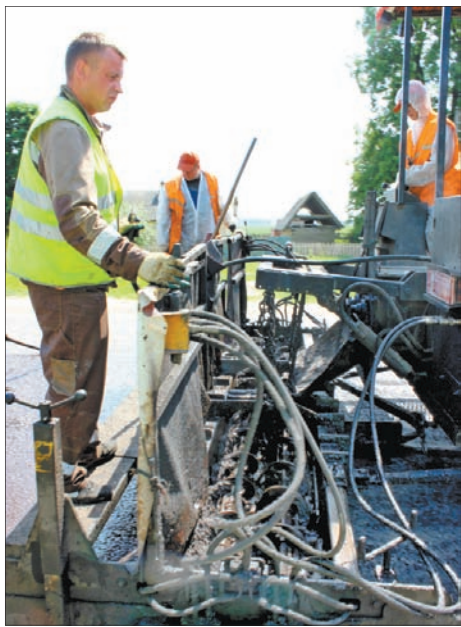
На участке автодороги Р93 Могилев – Бобруйск были продемонстрированы возможности применения технологии «Сларри Сил».
