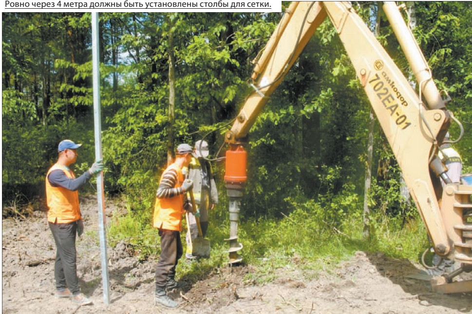
Ровно через 4 метра должны быть установлены столбы для сетки.
