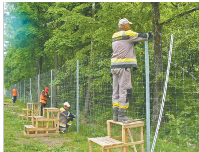
Каждый день бригада устанавливает 150 метров защитной сетки.
