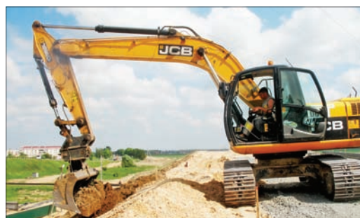
Идет планировка откосов на строительстве путепровода через железную дорогу на автодороге Р41 Слоним – Мосты – Скидель – граница Литовской Республики.
