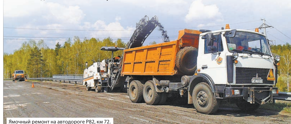
Ямочный ремонт на автодороге Р82, км 72.
