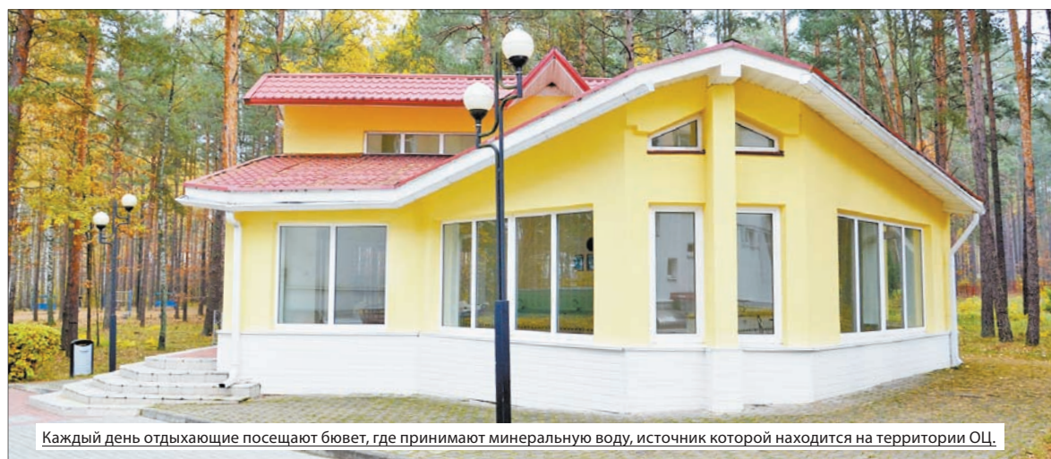
После обновления фасада жилой корпус оздоровительного центра преобразился.
