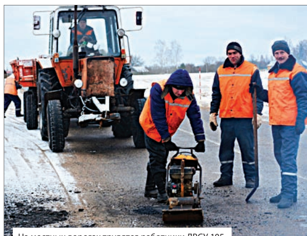
На местных дорогах трудятся работники ДРСУ-105.
