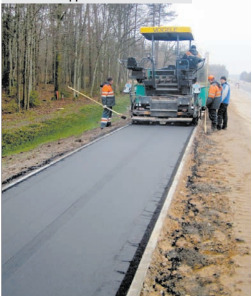
Асфальтобетонное покрытие пешеходной дорожки на км 218 выполняет ДСУ № 18.
